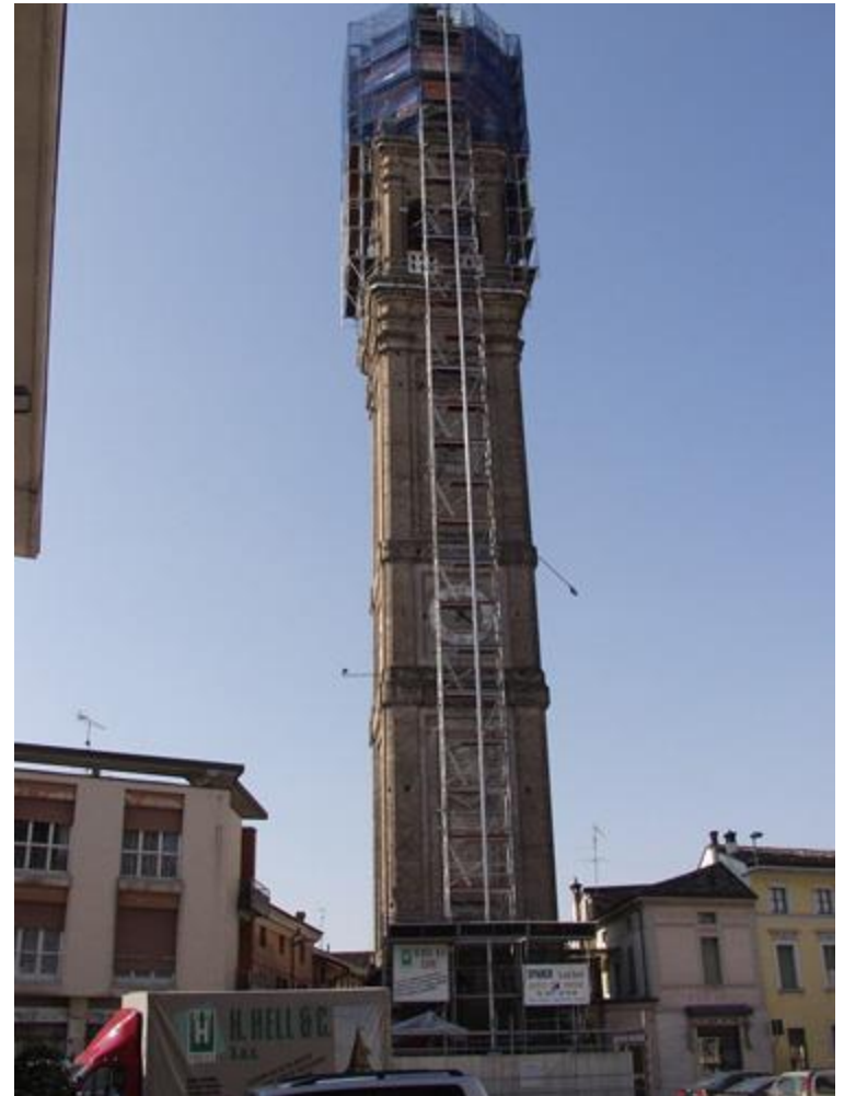
durante i lavori – ponteggio con montacarichi
