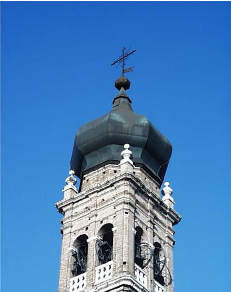
prima del intervento
